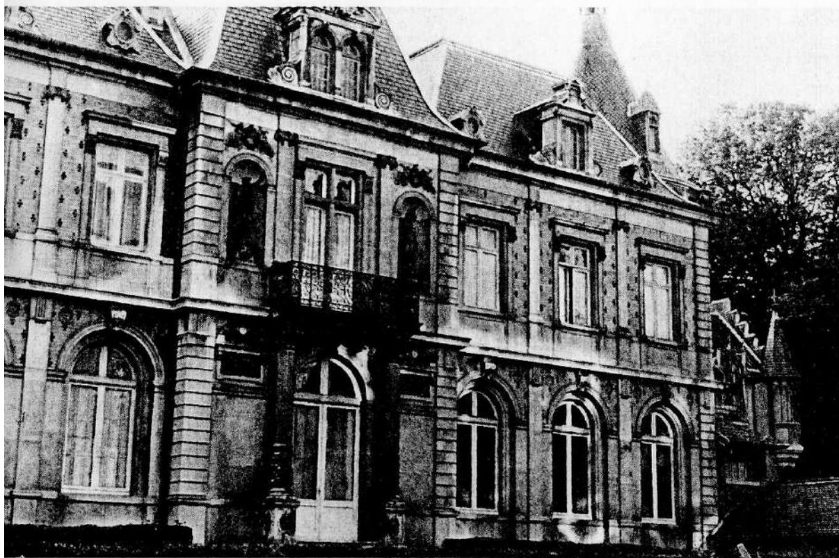
Château de l'Asnée. Façade nord.
